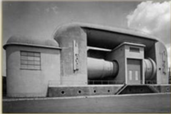
Sopra: Veduta esterna della Galleria aerodinamica a doppio ritorno.
